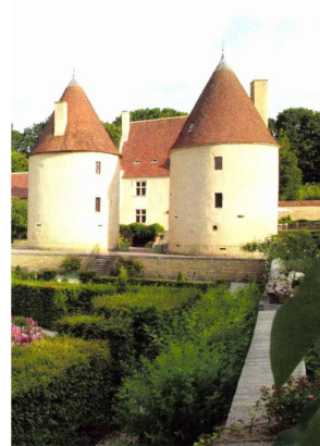
Le château de Corbelin (XIII e siècle), dans la Nièvre, entièrement rénové par ses anciens propriétaires, a été repris par un couple franco-suisse qui voulait un pied-à-terre en France. © D.R.
